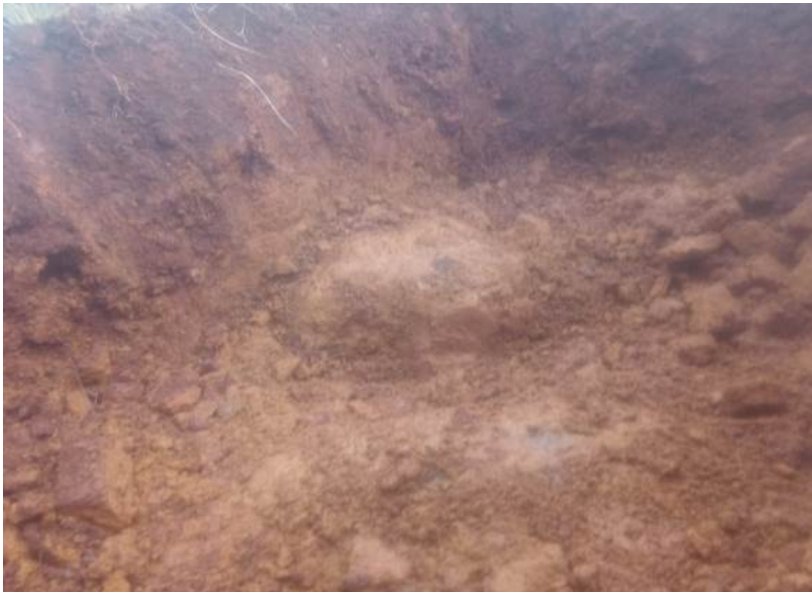
Foto 04: Vala de inspeção para verificação do substrato de paralisação (com pedras) do furo SP7.
