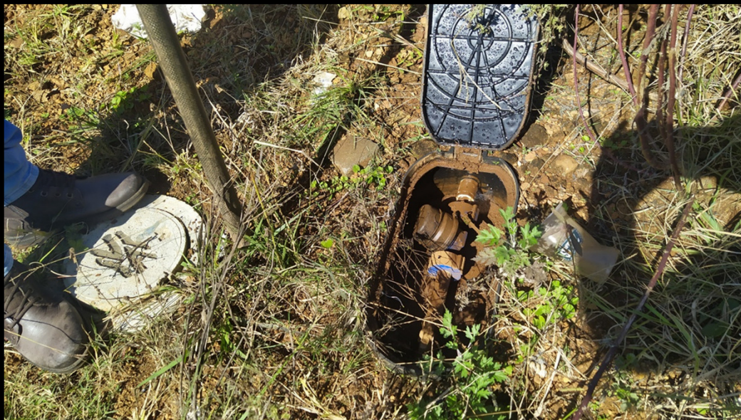
Hidrômetro e DTI Sanepar
